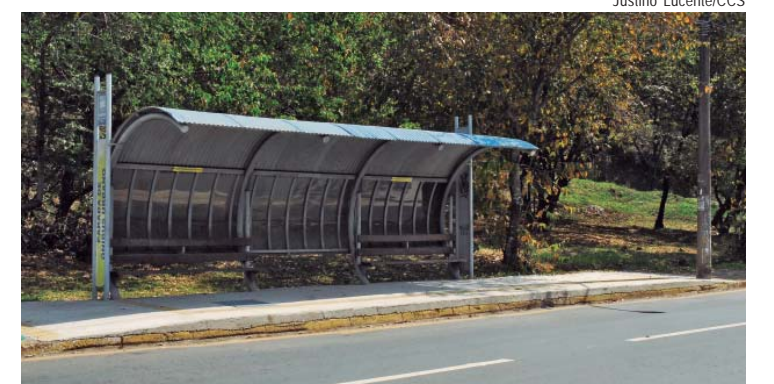
Calçada elevada para facilitar embarque em ônibus
